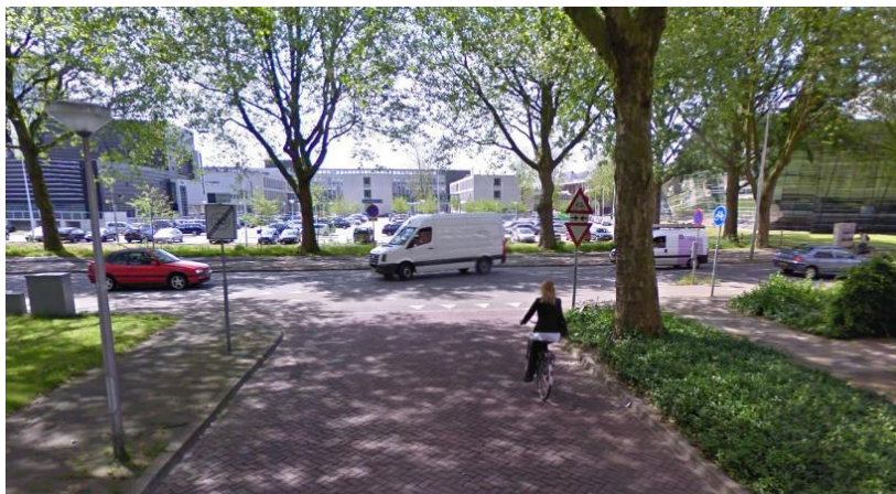
Figuur 7.2 Voorbeeld van een tweerichtingenfietspad met bebording als enige compenserende maatregel
