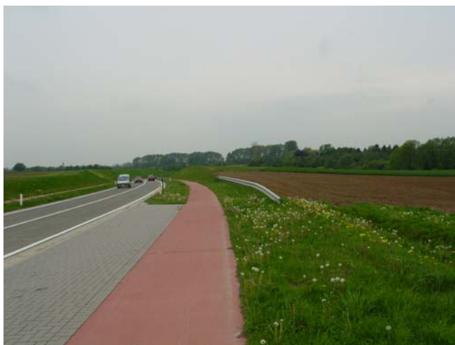
Vrijliggend fietspad Tienen
