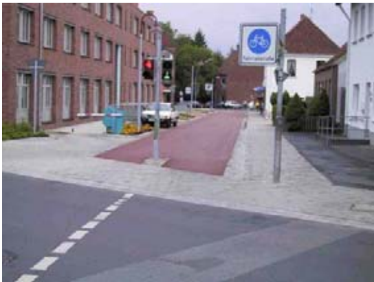
Bild 4-16: Umbau und Einrichtung der Jakob-Wolff-Straße als erste Fahrradstraße in Lingen
