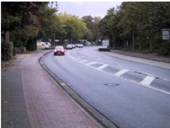
Bild 4-3: fehlende Überquerungshilfe an stark befahrenem Innenstadtring
