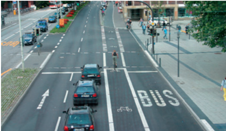
Kiel. Bij de recente herinrichting van het Stationsplein werd het plein verkleind ten bate van een bus- en een fietsstrook. De fietsstrook wordt rechts en links gemarkeerd door middel van een 25 cm brede witte doorgetrokken streep. Voorbij het kruispunt gaat de strook over in een (aanliggend) fietspad.
