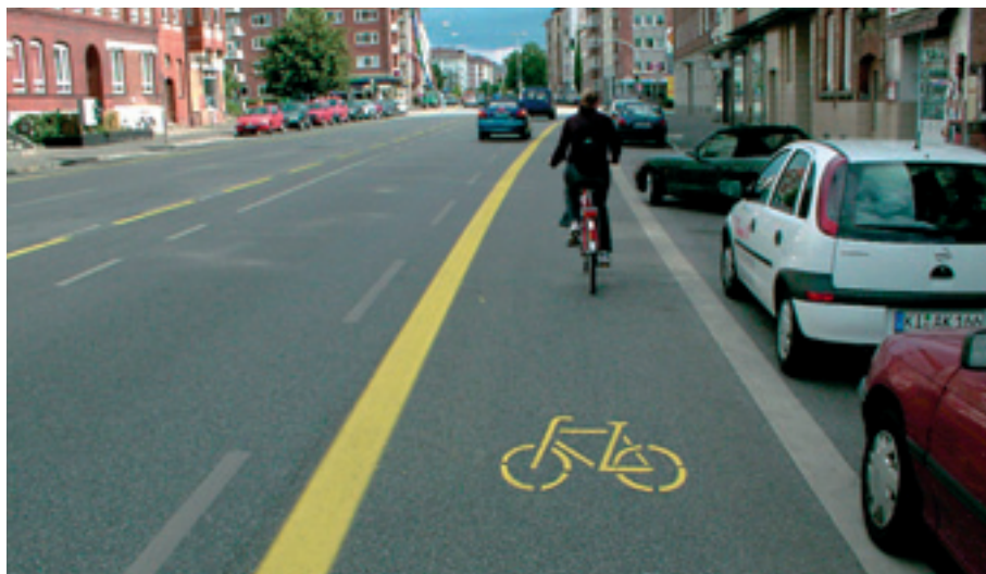
Kiel. Als proef (gele werk-in-uitvoering-markering) worden de drie rijbanen vervangen door twee rijbanen plus fietsstrook. Als het bevalt, komt er na enige tijd de permanente witte markering.
