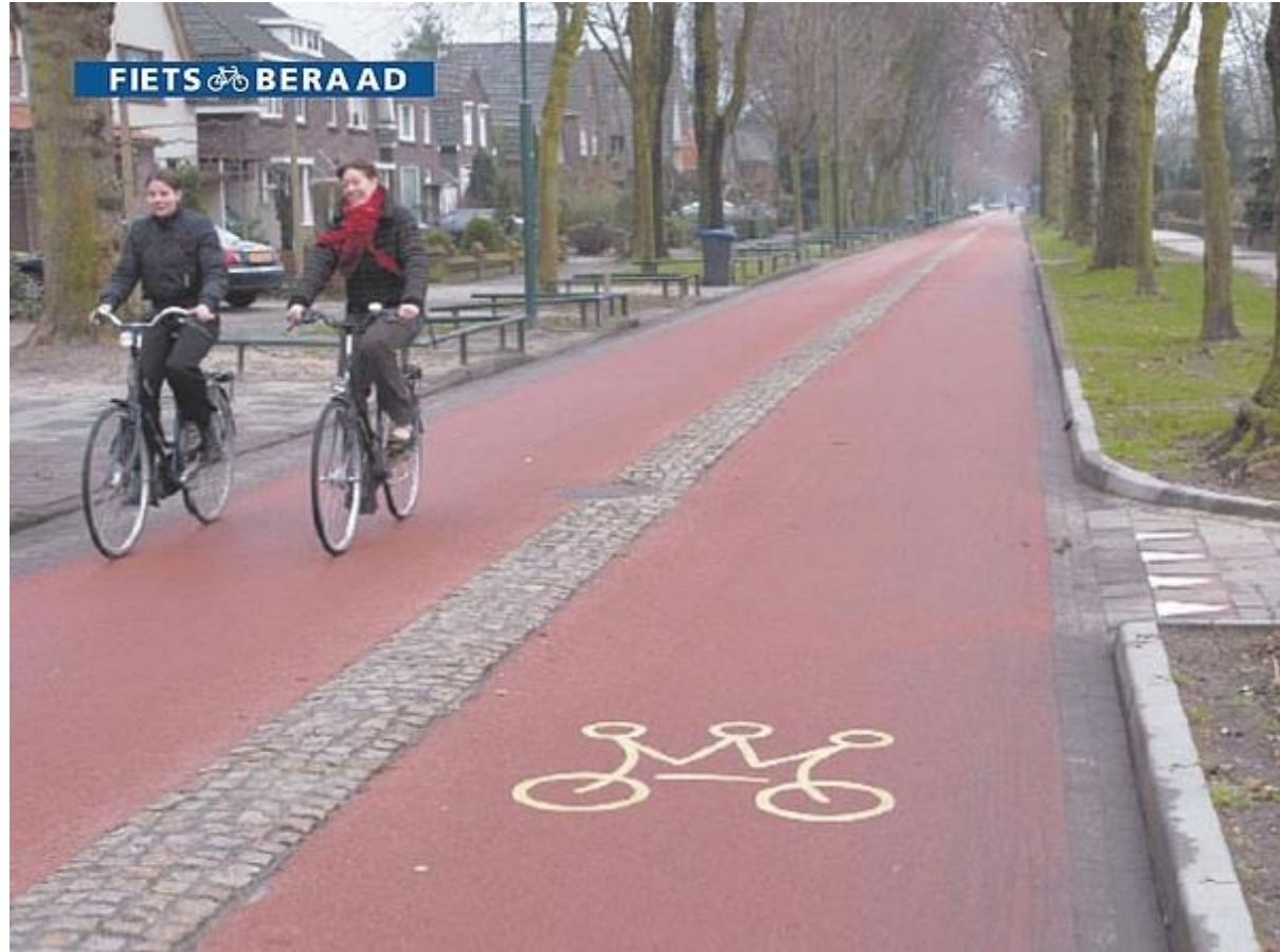
Lange fietsstraat met overrijdbare middenberm Oss, Hescheweg 2003
