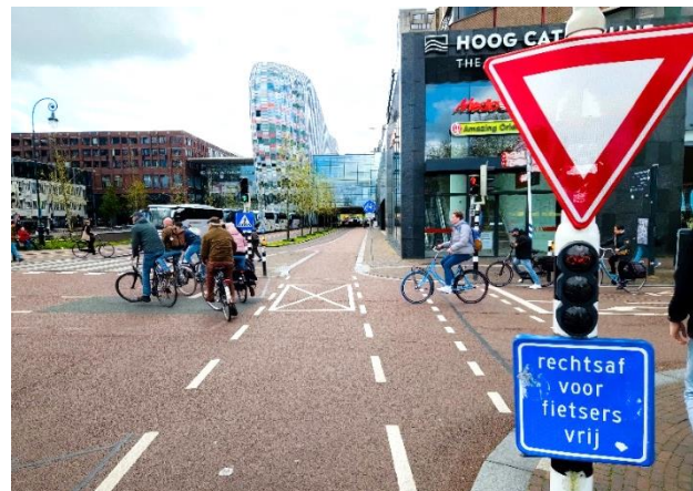
Figuur 7. Ook het dealkruispunt wordt met de VRI geregeld. Een optie voor drukke tweerichtingsfietspaden en krappe situaties.
