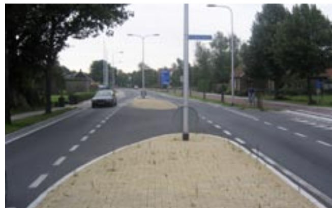
Middengeleiders maken de oversteek voor linksafslaand verkeer veiliger.
