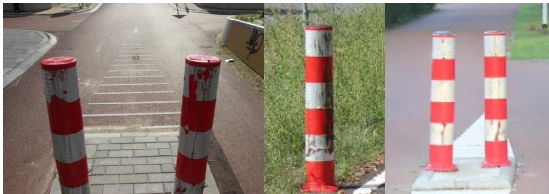
Figuur 12: Beschadigen op overrijdbare palen in Barneveld (links), Hardenberg (midden) en Houten (rechts).
