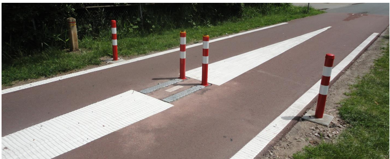
Figuur 6: Proeflocatie Enschede, voorbeeld van aanbevolen oplossing voor brede fietspaden. Door twee palen in het midden te plaatsen, staan ze niet op de natuurlijke rijlijn van fietsers. In dit keuzeschema worden wel dikkere palen aanbevolen.
