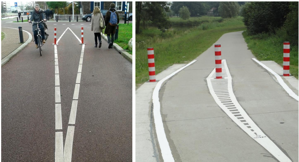
Figuur 7: Links: de markering leidt fietsers naar de palen i.p.v. langs de palen. Rechts proeflocatie in Zwolle met markering van VelopA, die fietsers langs de palen leidt.
