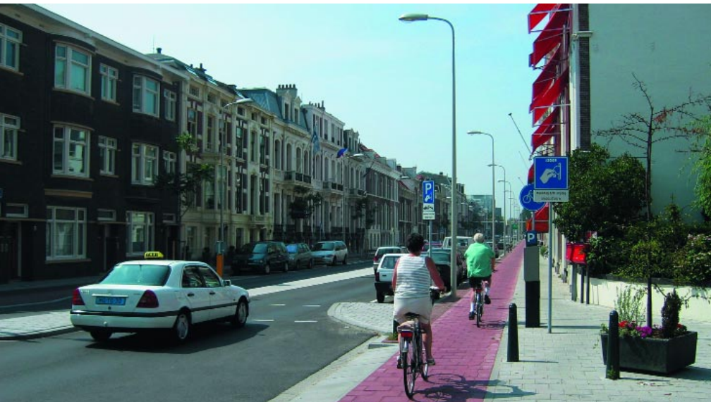
Den Haag kiest zoveel mogelijk voor vrijliggende fietspaden, overigens bij voorkeur uitgevoerd in asfalt.
