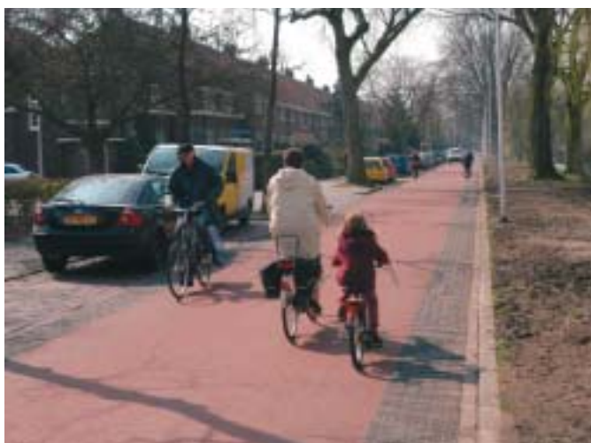
Ook op fietsstraten is asfalt gewenst
