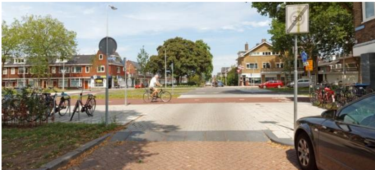
Figuur 8 Zichtbelemmering rechts van de zijweg. Het probleem is hier opgelost met een forse snelheidsremmer.
