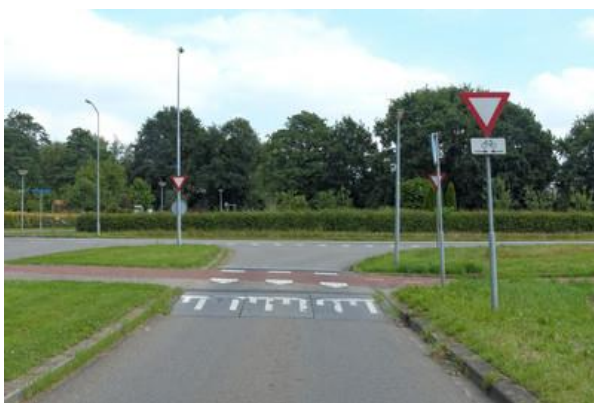
Figuur 11a (links) Fietspad die met een drempel over de zijweg geleid wordt (Assen)
