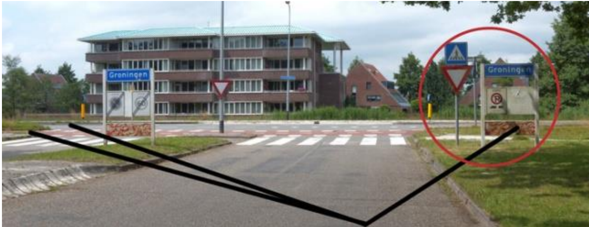
Figuur 9 Zichtbelemmering rechts van zijweg door verkeersborden
